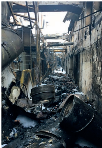
Die ausgebrannte Ofenhalle.
