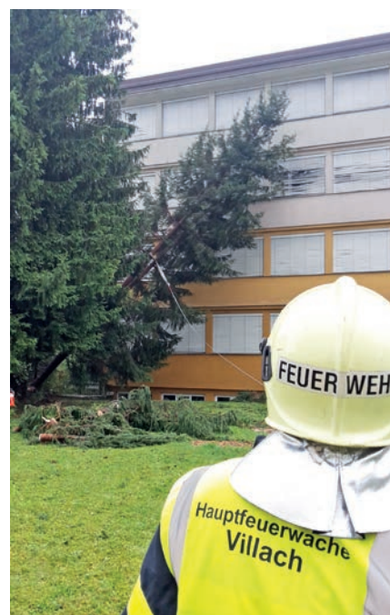
Bäume stürzten auf Häuser und beschädigten Fassaden.
