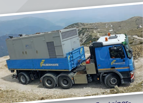
Transport 1100 kVA-Container- aggregat zum Sender Dobratsch
