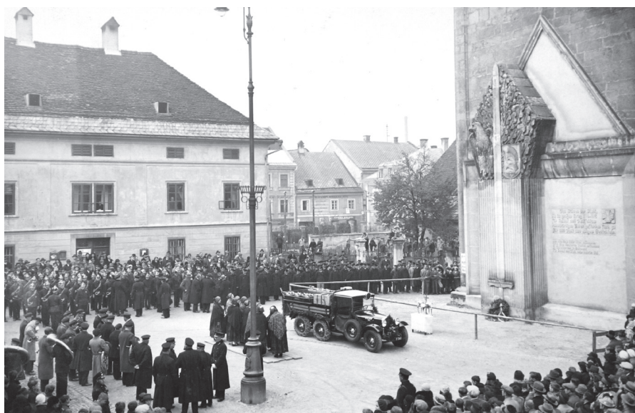
Rüstwagensegnung 1933 vor der Stadthauptpfarrkirche.
