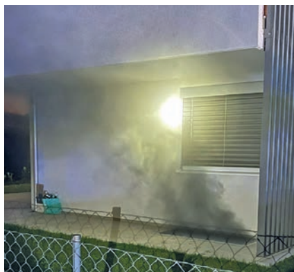
Rauch dringt aus den Lichtschächten
