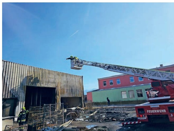
Ein Löschrupp lokalisiert über die Drehleiter Glutnester in der Fassadenfront.
