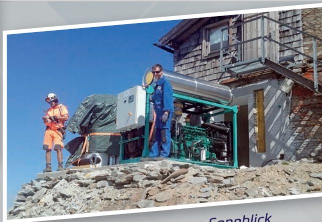
150 kVA-Aggregat-Einbau am Sonnblick
