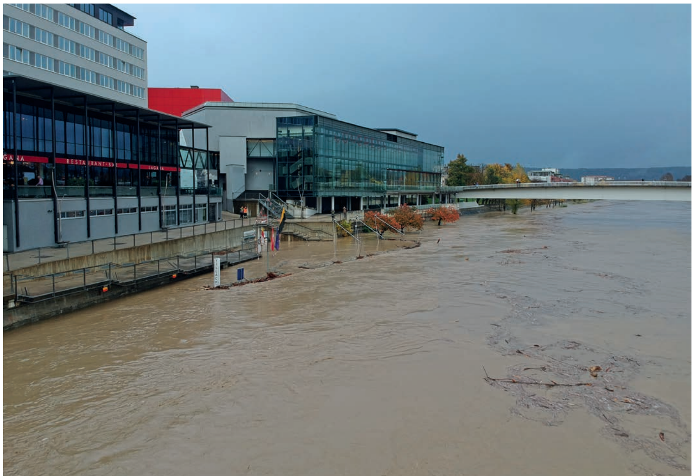
Die völlig überfluteten Bermen im Bereich der Anlegestelle Congress Center Villach mit Blick auf die Fußgängerbrücke.
