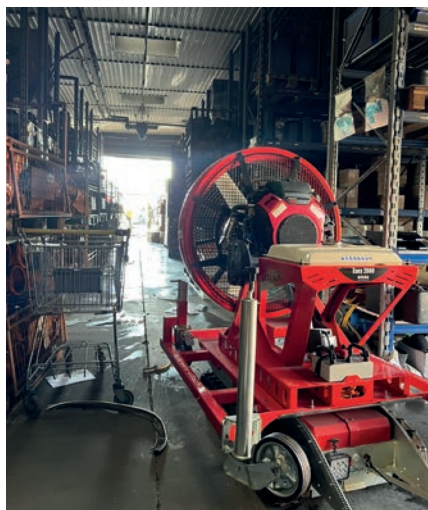
Einer unserer Großlüfter im Einsatz.
