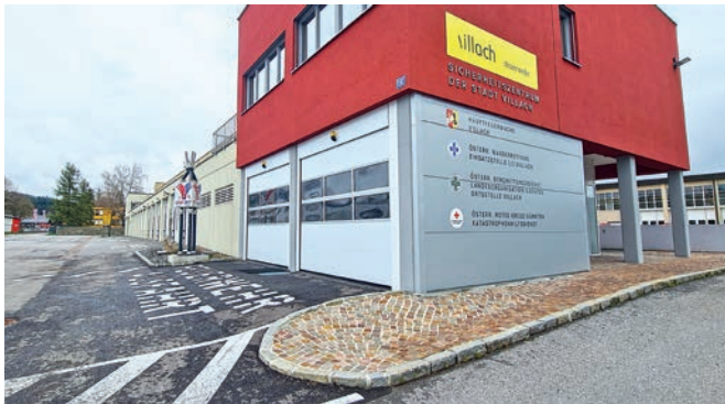
Unter dem Leitstellenzubau wurde eine kleine Gerätehalle umgesetzt.
